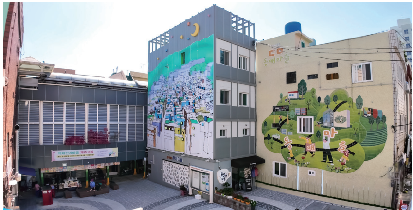
타일벽화 조성 및 벽면조명 설치
