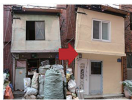
창호 보수 및 외벽 페인트
